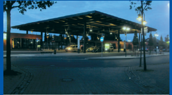
Neubau & Sanierung Bahnhofumfeld 1
