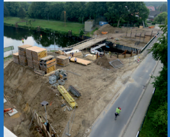
Zweite Fahrbahn über Schleusenquerung 1,2
